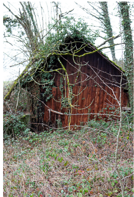
Img.114 : Bâtiment non assuré / Vue de l'Est
