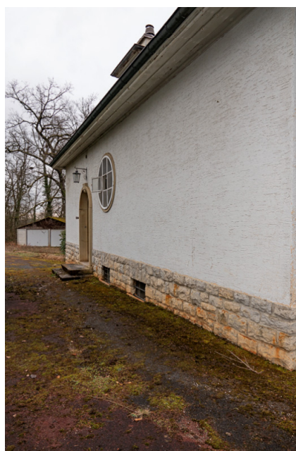
Img.66 : N°83C - Secteur Nord / Pied de façade
