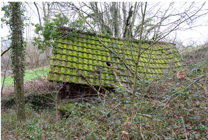
Img.113 : Bâtiment non assuré / Vue du Nord
