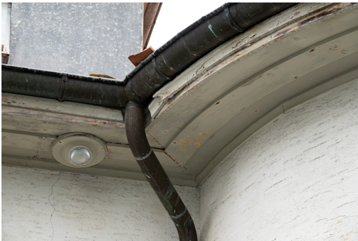
Img.81 : N°83C - Secteur Sud / Détail larmier et berceau d'avant-toit
