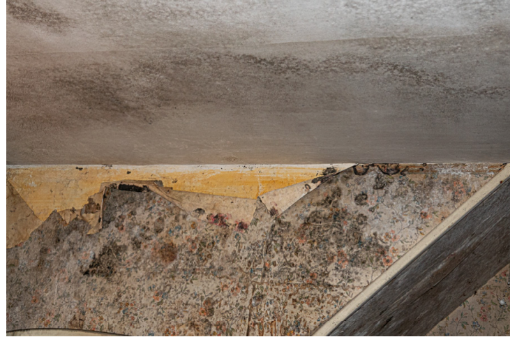
Img.50 : N°83C - ET1 / Détail chambre Est (plafond)
