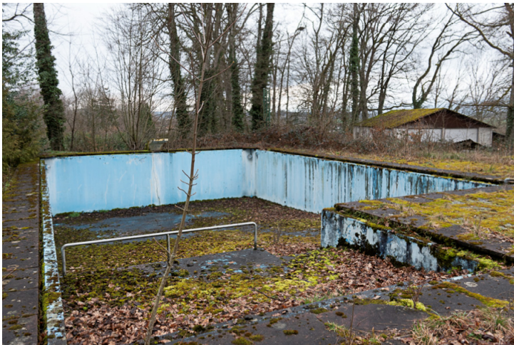
Img.93 : Secteur Nord / Piscine désaffectée
