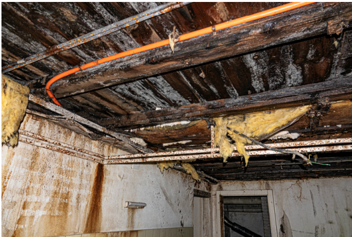
Img.57 : N°83C - SS / Détail plafond (2ème buanderie)
