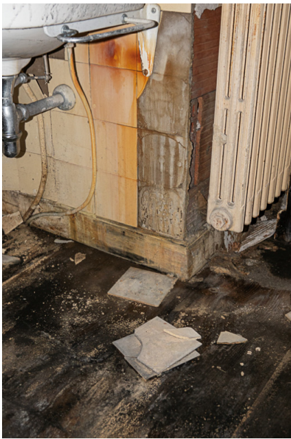
Img.49 : N°83C - ET1 / Détail chambre Est (sol + paroi)
