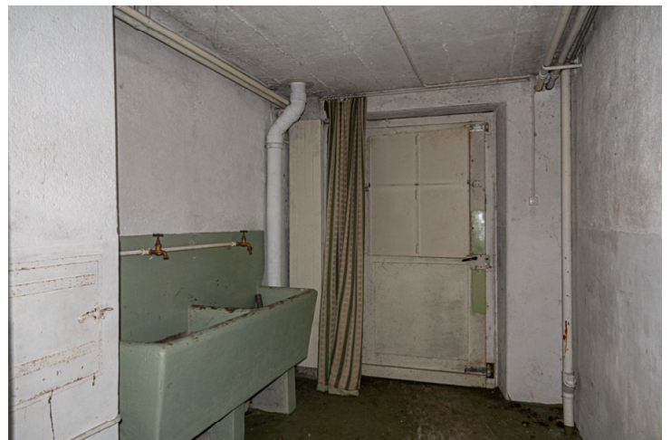
Img.6 : N°83C - Sous-sol / Accès ext. Ouest
