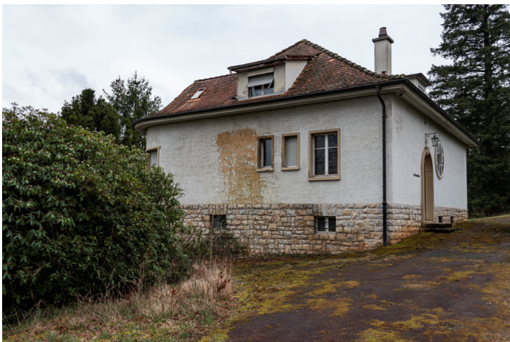
Img.89 : N°83C - Secteur Est / Façade Est
