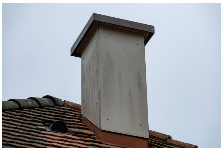
Img.69 : N°83C - Secteur Ouest / Souche de cheminée
