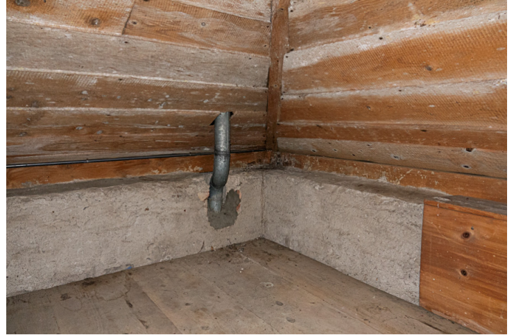
Img.38 : N°83C - ET1 / Combles Nord-Est
