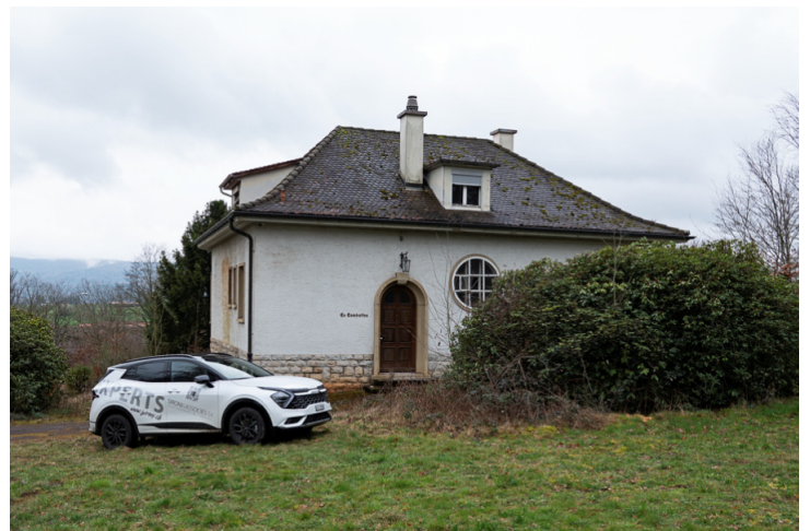
Img.60 : N°83C - Secteur Nord / Façade Nord
