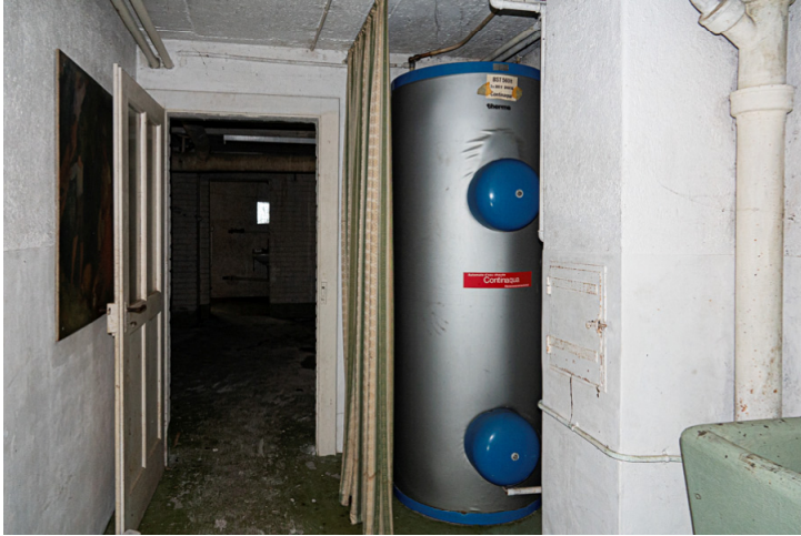
Img.7 : N°83C - Sous-sol / Accès ext. Ouest
