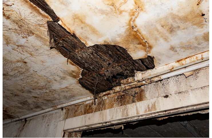
Img.56 : N°83C - SS / Détail plafond (1ère buanderie)
