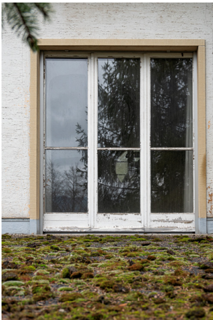
Img.83 : N°83C - Secteur Sud / Détail porte-fenêtre
