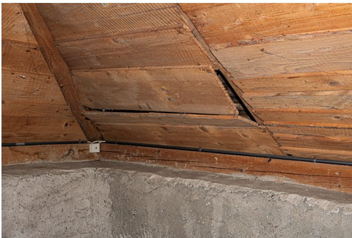
Img.47 : N°83C - ET1 / Combles
