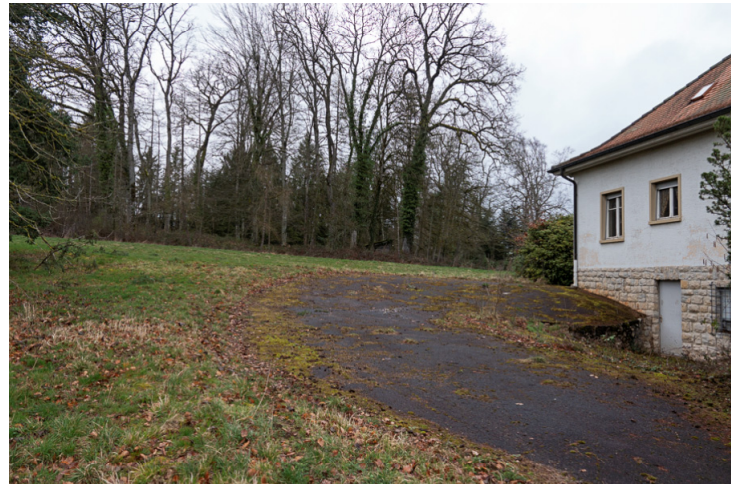
Img.74 : N°83C - Secteur Ouest / Cheminement en enrobé
