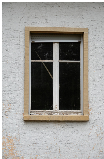
Img.68 : N°83C - Secteur Ouest / Détail fenêtres et stores
