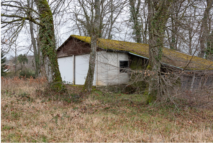
Img.121 : N°83G / Façade Ouest
