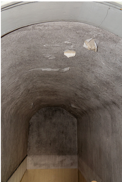
Img.53 : N°83C - ET1 / Détail plafond (cage d'escalier)
