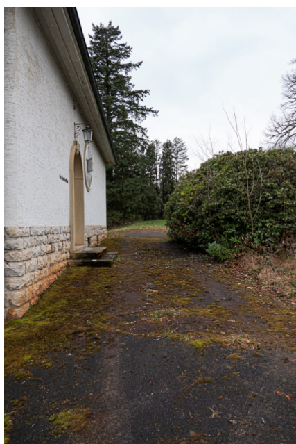
Img.63 : N°83C - Secteur Nord / Passage en enrobé
