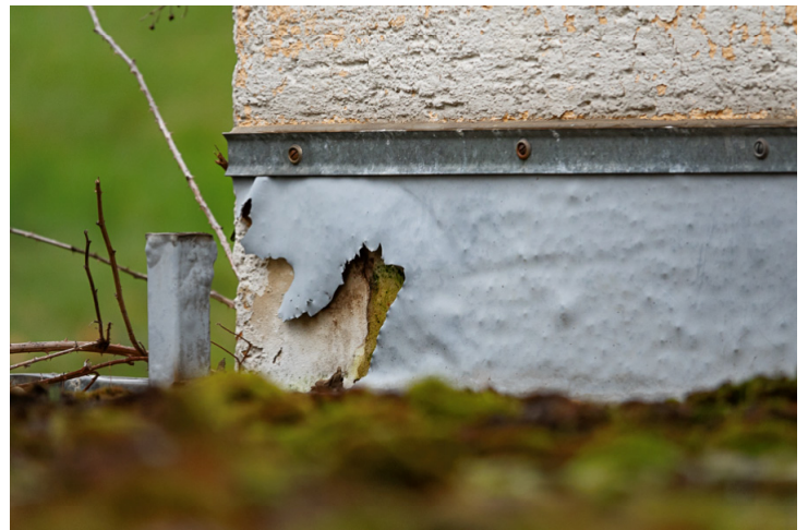
Img.82 : N°83C - Secteur Sud / Détail remontée d'étanchéité terrasse
