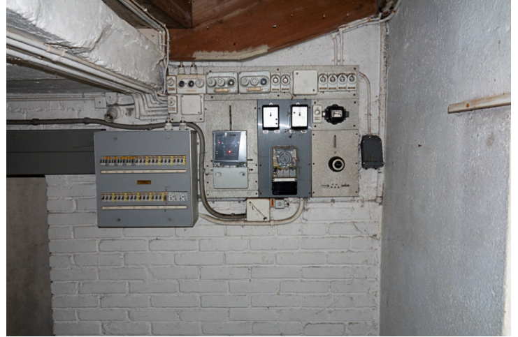
Img.2 : N°83C - Sous-sol / Distribution
