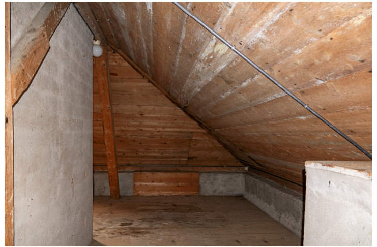
Img.44 : N°83C - ET1 / Combles
