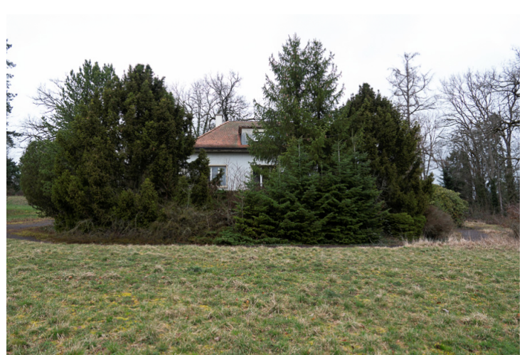
Img.76 : N°83C - Secteur Sud / Vue générale
