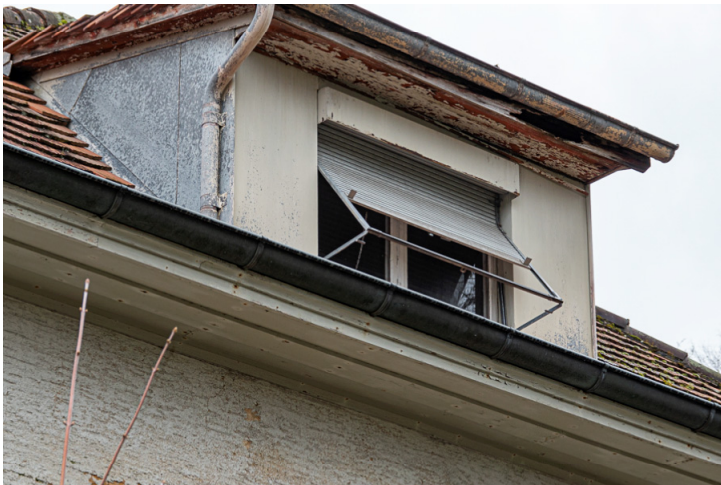
Img.87 : N°83C - Secteur Est / Lucarne Est
