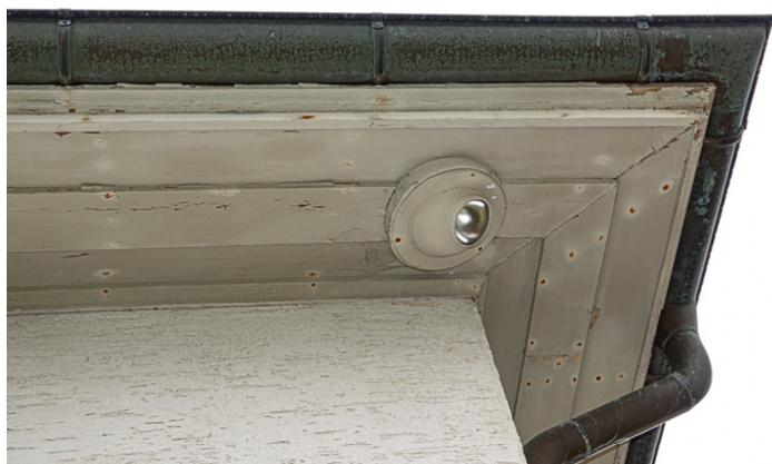
Img.65 : N°83C - Secteur Nord / Angle Nord-Ouest de la toiture
