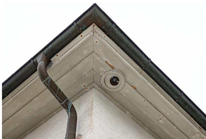
Img.64 : N°83C - Secteur Nord / Angle Nord-Est de la toiture
