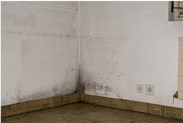
Img.15 : N°83C - Sous-sol / Buanderie 4 (Sud-Ouest)
