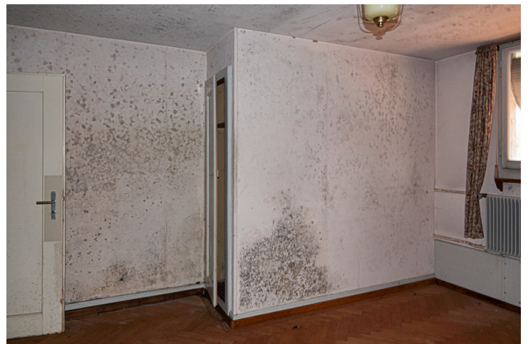
Img.42 : N°83C - ET1 / Chambre Sud
