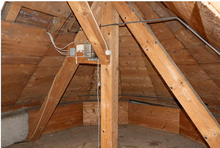
Img.39 : N°83C - ET1 / Combles Est
