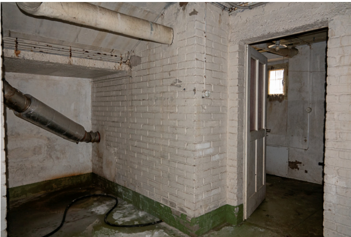
Img.3 : N°83C - Sous-sol / Distribution
