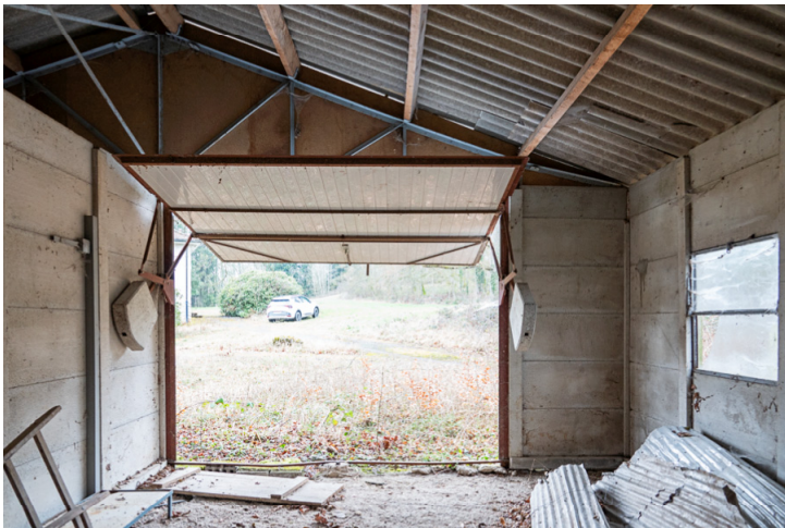
Img.99 : N°83G / Garage Nord
