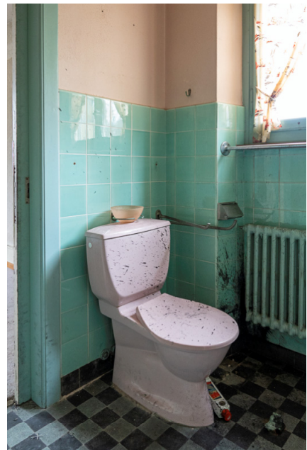
Img.30 : N°83C - Rez / Salle de bain Ouest
