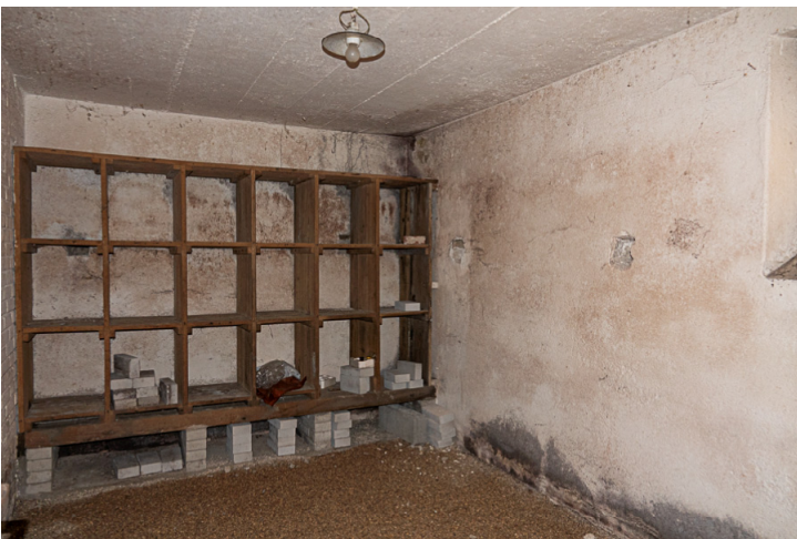
Img.5 : N°83C - Sous-sol / Cave Nord-Ouest
