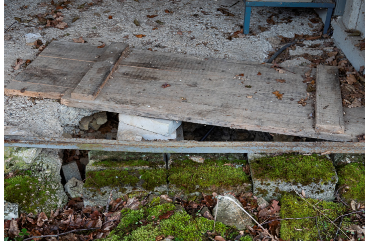
Img.98 : N°83G / Garage Nord
