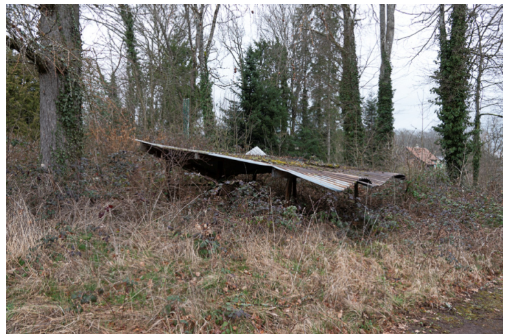
Img.96 : Secteur Nord / Élément à déconstruire
