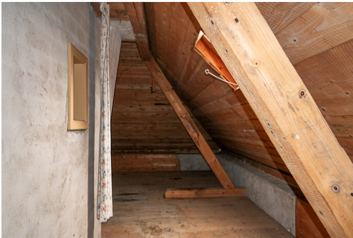
Img.45 : N°83C - ET1 / Combles
