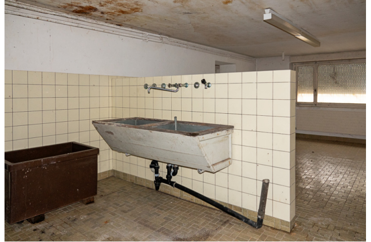
Img.8 : N°83C - Sous-sol / Buanderie 1
