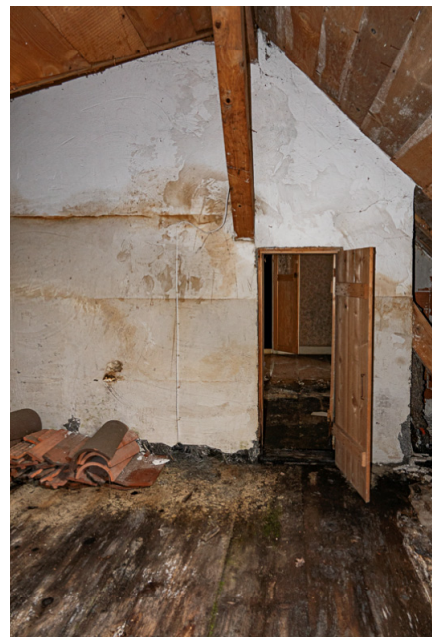
Img.40 : N°83C - ET1 / Combles Est
