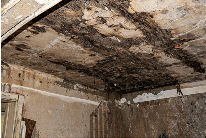
Img.55 : N°83C - RCH / Détail plafond (salon Sud)
