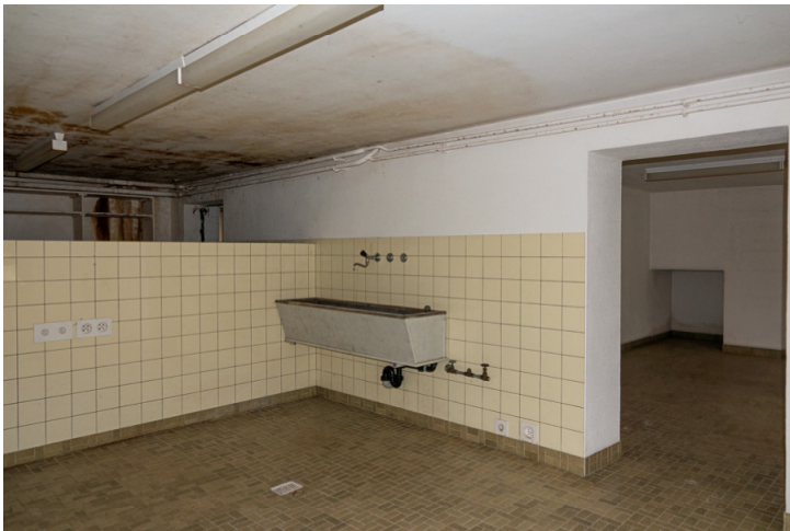
Img.9 : N°83C - Sous-sol / Buanderie 1
