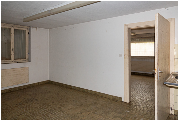
Img.13 : N°83C - Sous-sol / Buanderie 3 (Sud)
