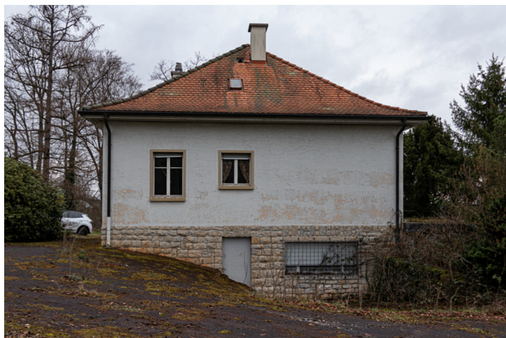
Img.67 : N°83C - Secteur Ouest / Façade Ouest
