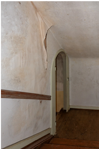
Img.35 : N°83C - ET1 / Escalier d'accès entre RCH et ET1
