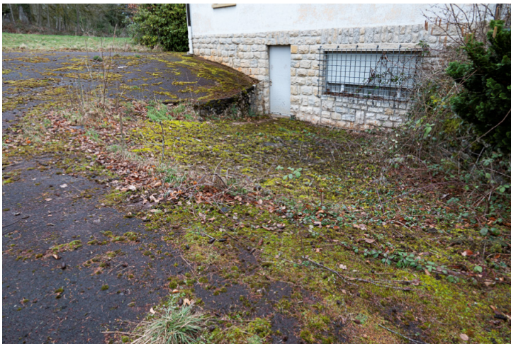
Img.75 : N°83C - Secteur Ouest / Rampe d'accès au sous-sol
