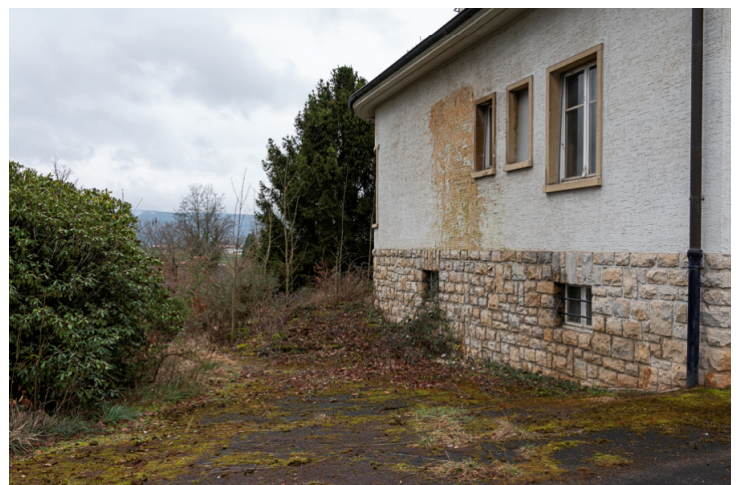
Img.90 : N°83C - Secteur Est / Surface en enrobé, pied de façade
