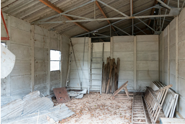
Img.97 : N°83G / Garage Nord
