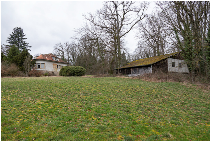
Img.117 : N°83G et 83C / Vue du Sud-Est
