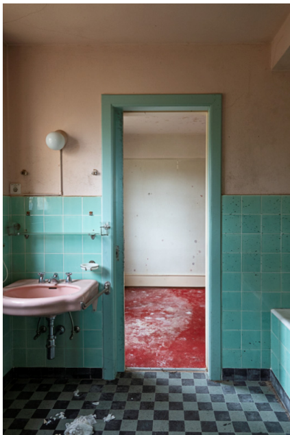
Img.29 : N°83C - Rez / Salle de bain Ouest
