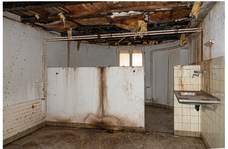
Img.10 : N°83C - Sous-sol / Buanderie 2 (Sud-Est)
