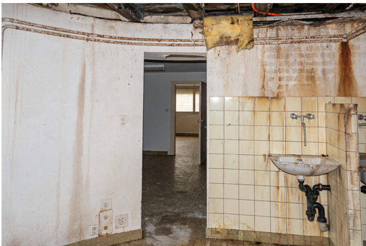
Img.11 : N°83C - Sous-sol / Buanderie 2 (Sud-Est)
