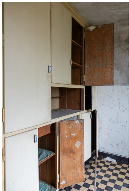
Img.22 : N°83C - Rez / Cuisine Nord-Est
