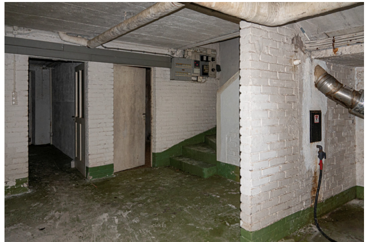
Img.4 : N°83C - Sous-sol / Distribution
