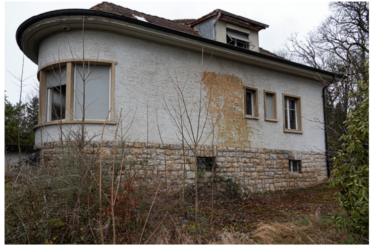
Img.86 : N°83C - Secteur Est / Façade Est
