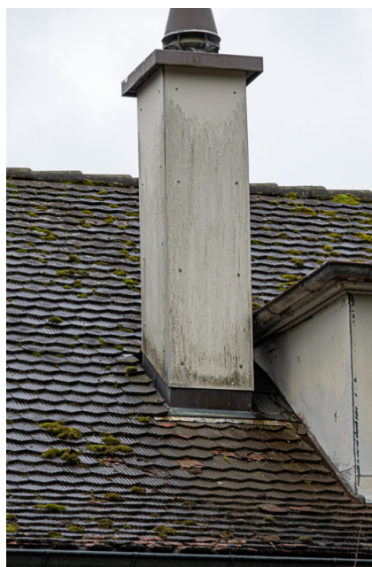
Img.62 : N°83C - Secteur Nord / Souche de cheminée
