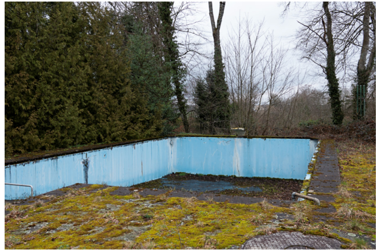
Img.92 : Secteur Nord / Piscine désaffectée
