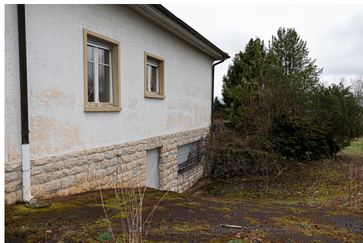
Img.72 : N°83C - Secteur Ouest / Pied de façade
