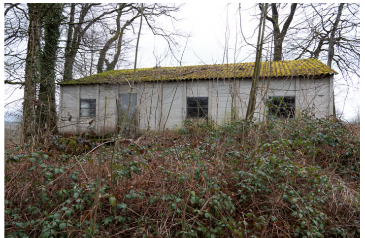
Img.108 : N°83G / Façade Nord
