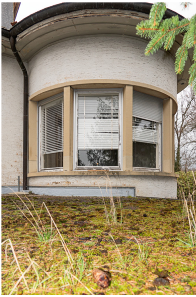
Img.79 : N°83C - Secteur Sud / Angle Sud-Est du volume d'habitation
