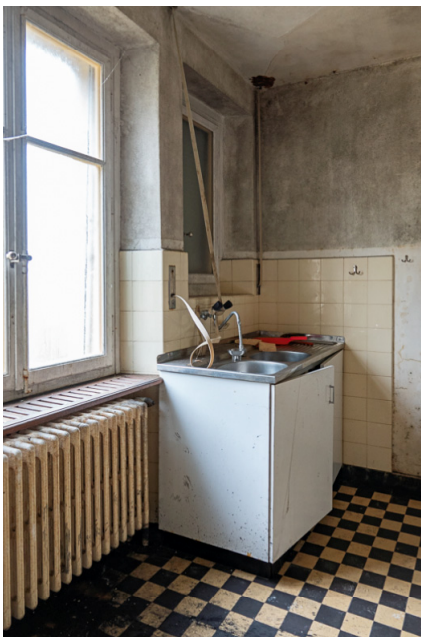
Img.21 : N°83C - Rez / Cuisine Nord-Est
