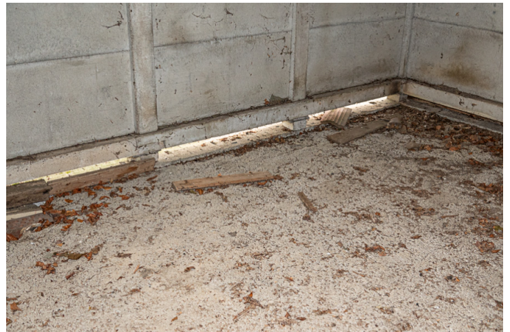
Img.106 : N°83G / Réduit Est (détail socle)
