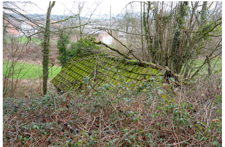
Img.112 : Bâtiment non assuré / Vue de l'Ouest
