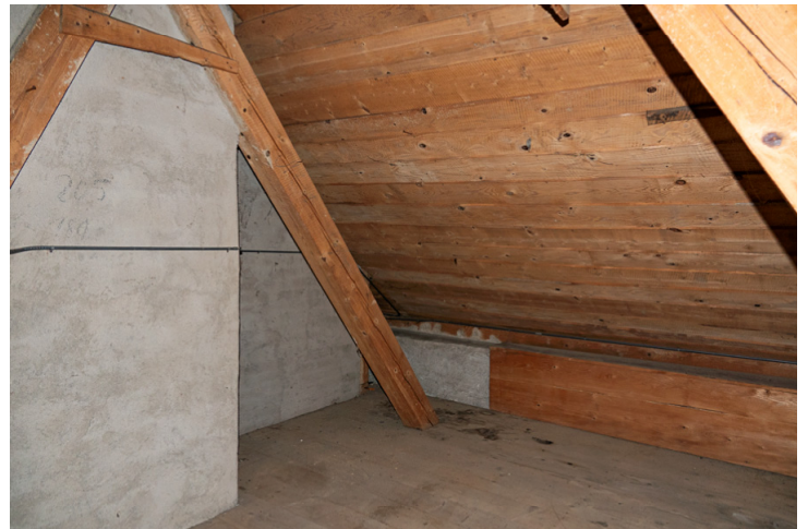
Img.46 : N°83C - ET1 / Combles
