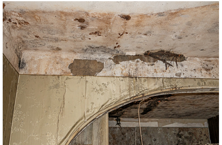
Img.54 : N°83C - RCH / Détail plafond (salon Sud)
