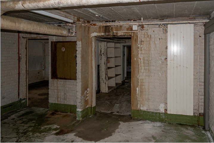
Img.1 : N°83C - Sous-sol / Distribution
