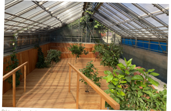
Rénovation de la serre méditerranéenne.
