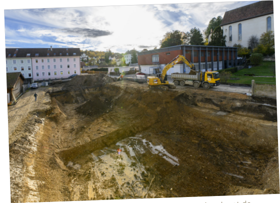
Début des travaux de terrassement du Centre de recherche et de conservation.
