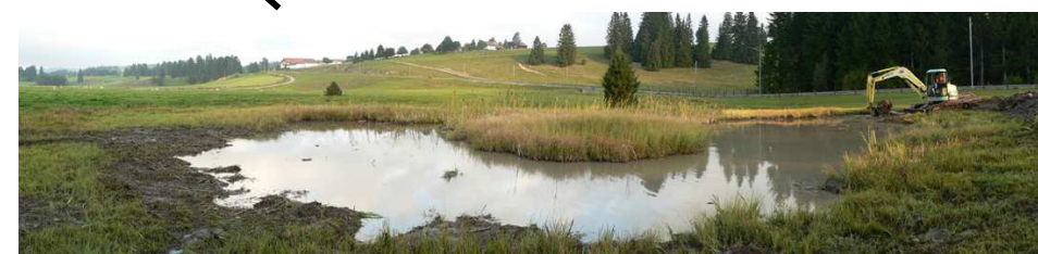
Curage de la mare sis dans le pâturage en zone tampon.
