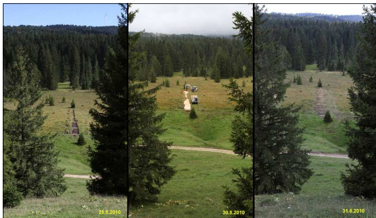
Comblement des canaux de drainage à l'aide de sciure de bois.
