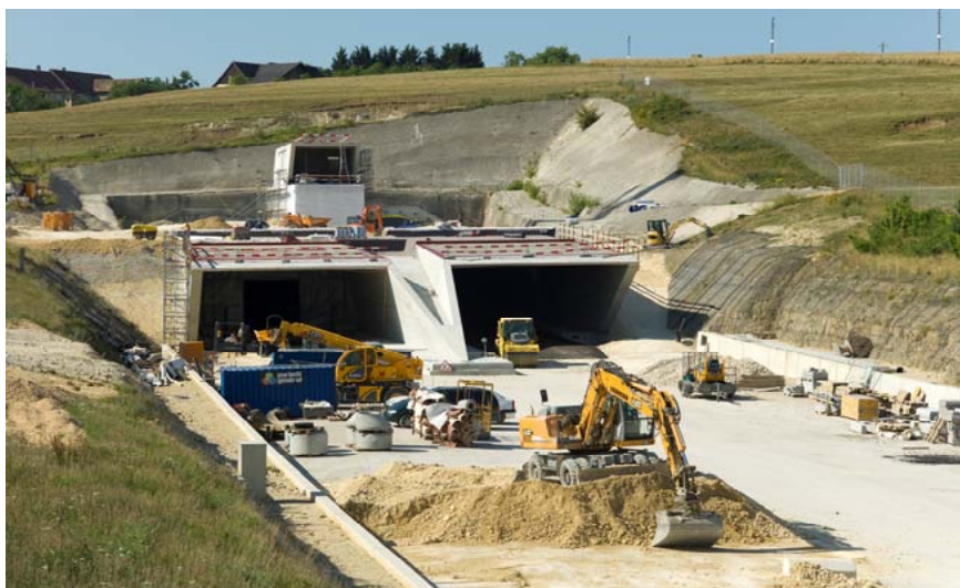
A16 - Portail nord tunnel de Bure.
