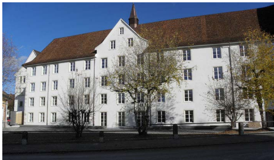
Porrentruy - Rénovation du bâtiment "Le Séminaire"
