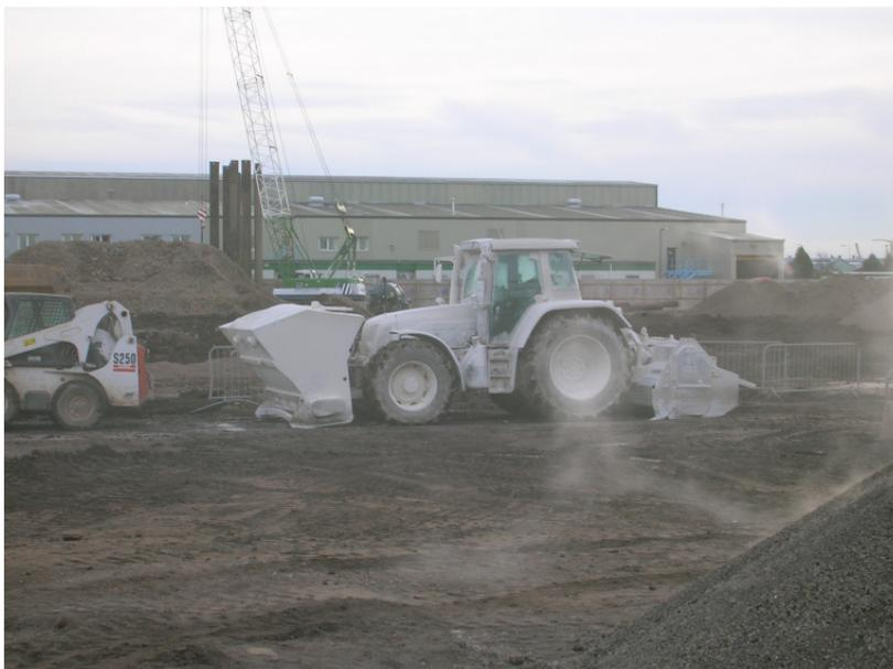
Figure 8 : Tracteur avec garniture de dosage (à l'avant) et fraise (Grimsby, UK)
