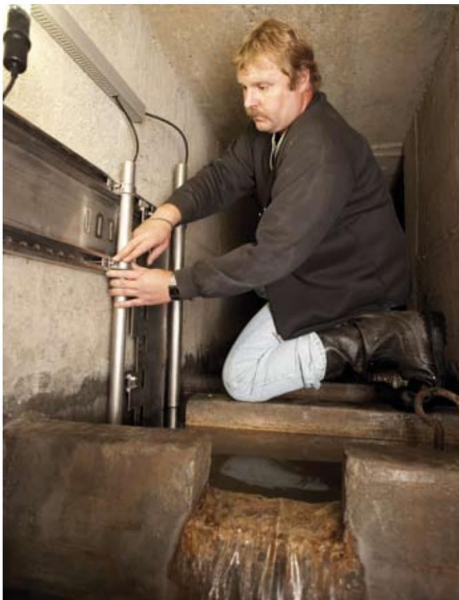
*Installation, dans un captage, d'appareils électroniques de mesure consultables à distance.*
