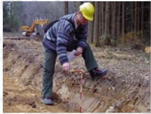
Le SPSC surveille les travaux de terrassement; il est habilité à donner des instructions sur le chantier.
