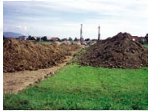
Entreposage provisoire de matériaux du sous-sol (à gauche) et de la couche supérieure du sol (à droite) juste avant l'ensemencement.
