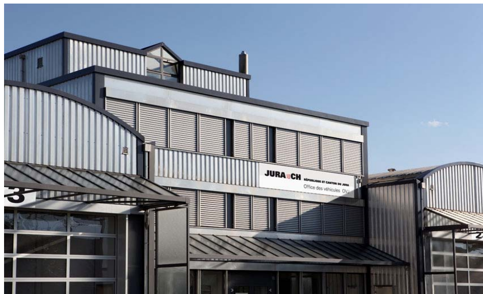
Delémont - Office des véhicules - Communance 45
