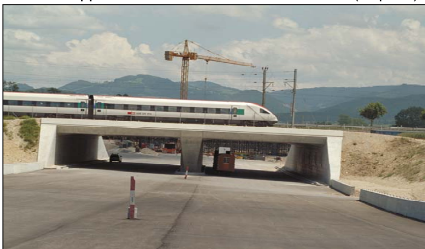
Chantier de la Transjurane : Evitement de Delémont - passage de la Ballastière
