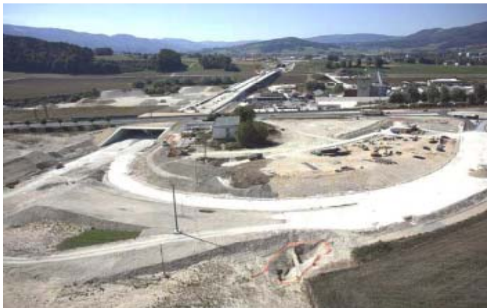
Chantier de la Transjurane à l'est de Delémont : giratoire de la route cantonale Delémont - Courrendlin
