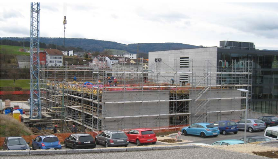
Porrentruy - Centre professionnel - extension
