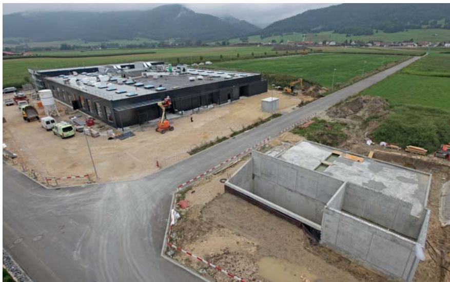
Le chantier de la ZAM à Glovelier.
