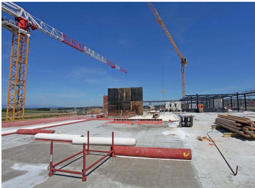
Le chantier du Swatch Group, à Boncourt. Le site sera opérationnel début 2013.
