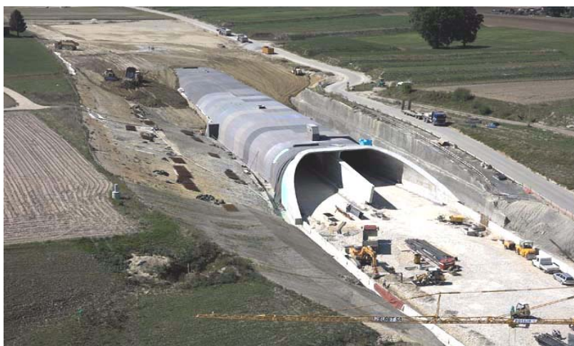
Chantier de la Transjurane à Delémont : Tranchée couverte de la Beuchille
