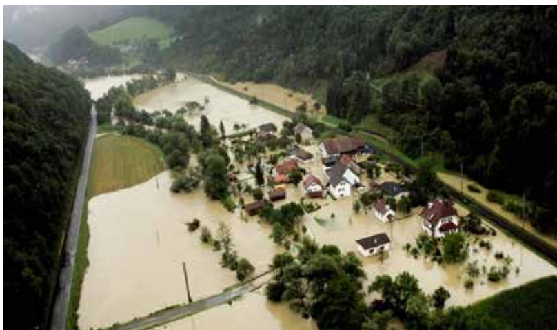
Inondations d'août 2007 dans le hameau de Riedes-Dessus (Soyhières).
