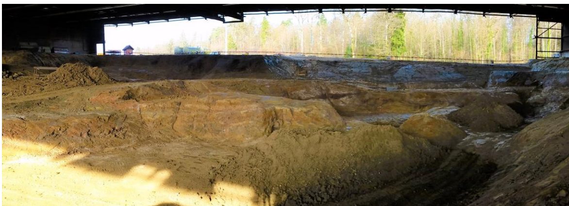
Photo : Décharge chimique de Bonfol - L'encaissant assaini de la partie nord, vue depuis le sud vers le nord, mars 2017.
