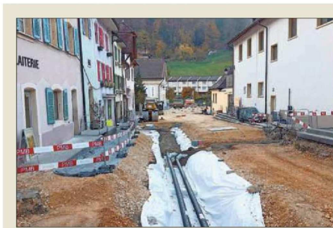
Un ancien méandre du Doubs a été retrouvé le long de la rue Verdat, ici en photo lors du chantier en novembre dernier, avec de nombreux vestiges très bien conservés... PHOTO AD
