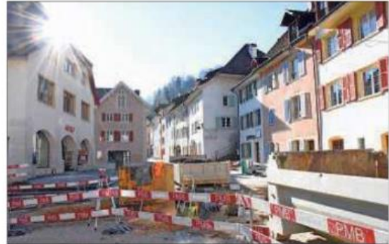
La rue du 23-Juin est en travaux à Saint-Ursanne.
