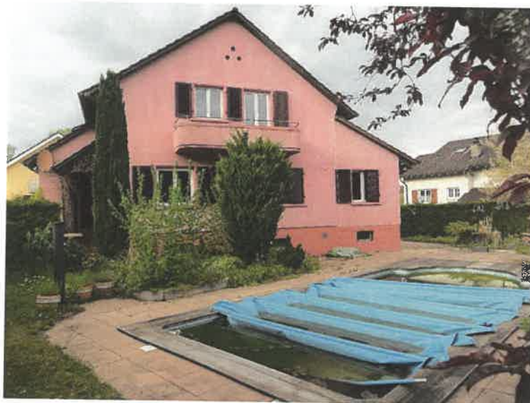
Face Sud, bassin
