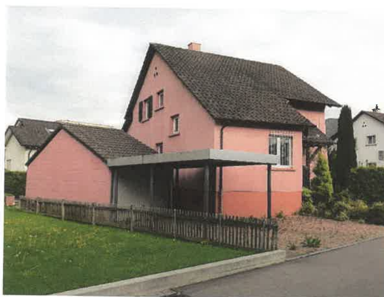
Face Nord-Ouest, accès propriété
