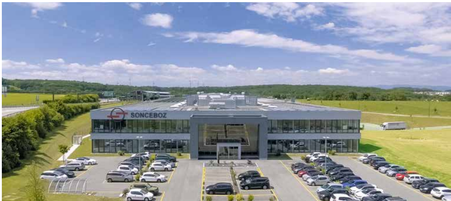
L'usine de Boncourt du groupe Sonceboz avant le début des travaux d'agrandissement.
