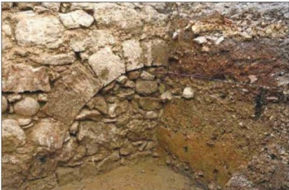
La construction voûtée, dans le rempart médiéval qui marquait la limite de la ville.
