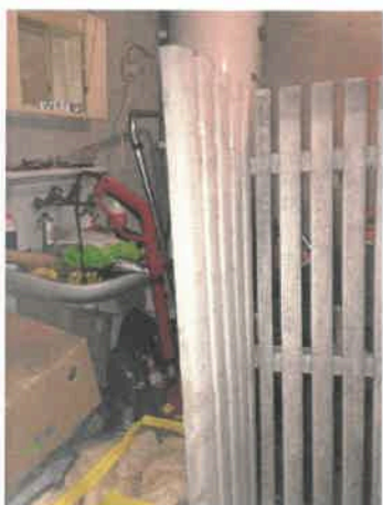
Ancienne douche, lavabo, WC
