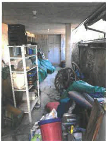
Passage sous balcon étage 1
