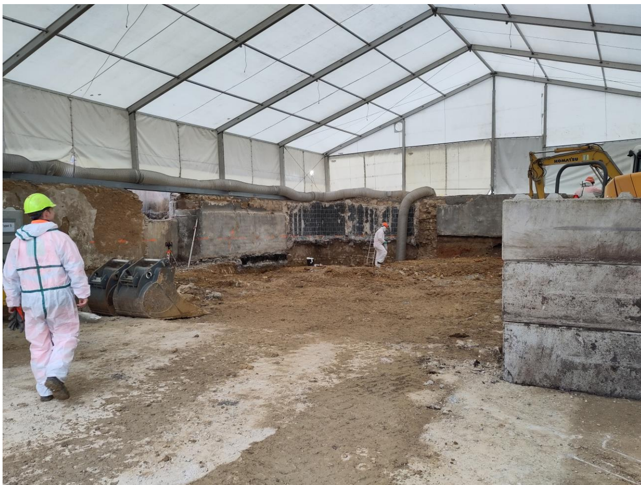
Assainissement du foyer n°2 de l'ancienne Onivia à Porrentruy - 2023
