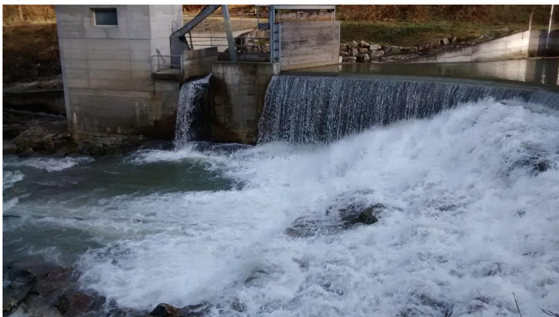
Centrale hydroélectrique des Entrepôts de Bellerive SA à Soyhières
