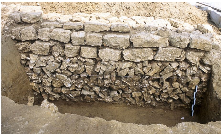
Fondation de mur. Époque romaine. Alle- Les Aiges. ◀
