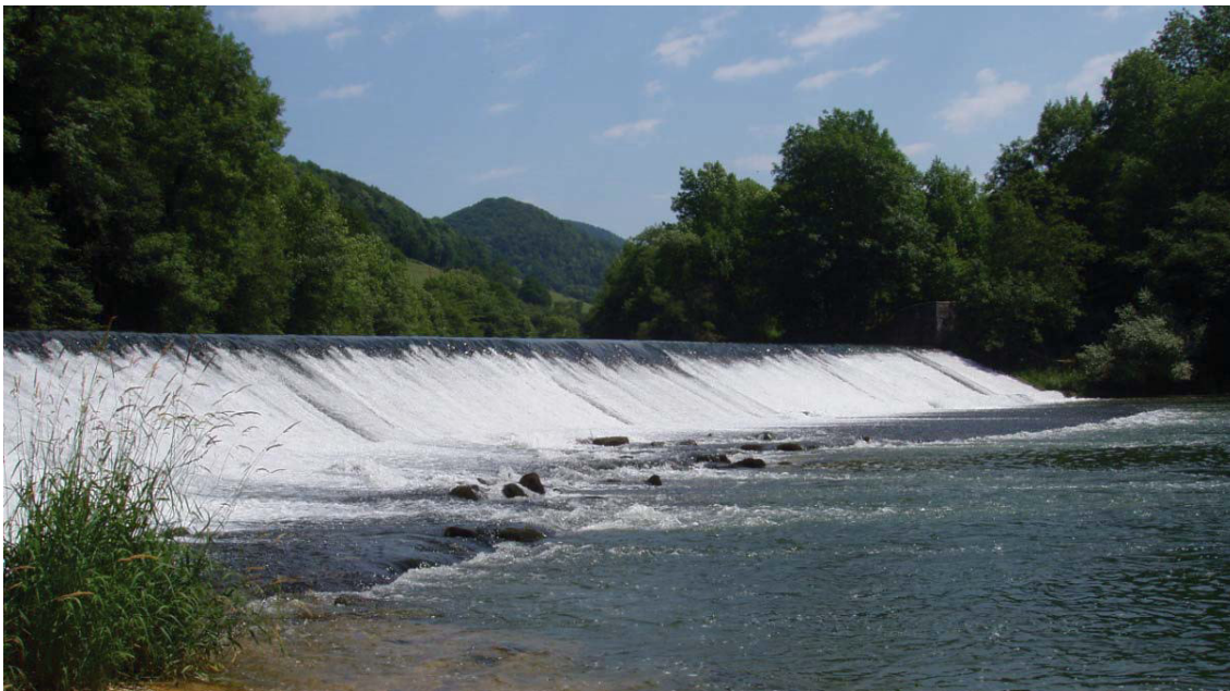
Seuil de Bellefontaine. Barrage d'une hauteur de 7 m et d'une largeur de 85 m totalement infranchissable pour l'apron.
