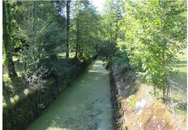
Figure 1.7 Canal d'amenée d'eau vers la centrale
