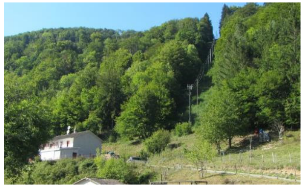
Figure 1.9 Ligne aérienne Ocourt – Fontenais située à quelques centaines de mètres de la centrale.
