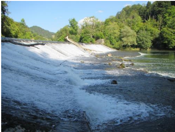
Figure 1.4 Seuil d'une hauteur de 3 m avec semelle bétonnée en aval
