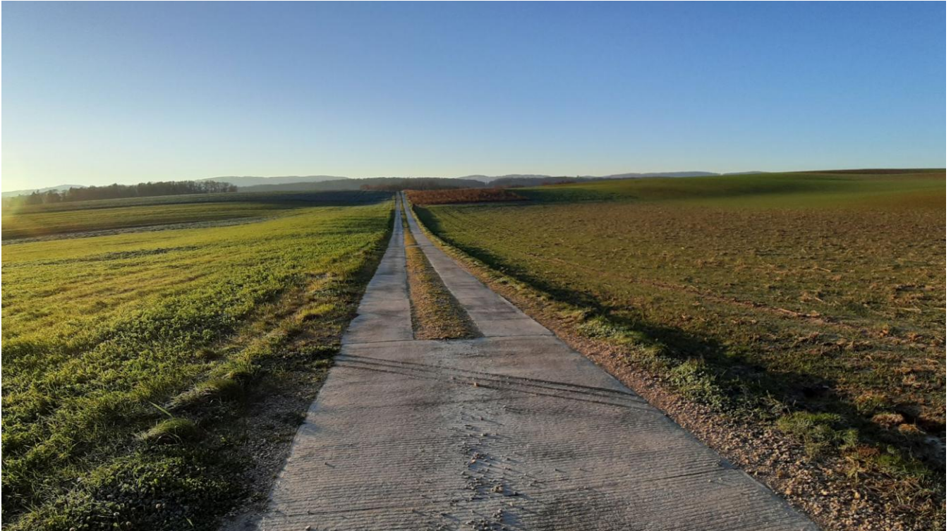
Bandes de roulement béton réalisé dans le cadre d'un remaniement parcellaire
