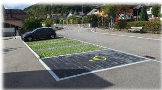
Désimperméabilisation de places de stationnement à Glovelier
