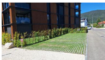
Revêtement « modulaire » : Dalles alvéolées engazonnées
