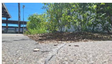
Revêtement « non lié » : Copeaux de bois
