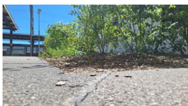
Revêtement « non lié » : Copeaux de bois
