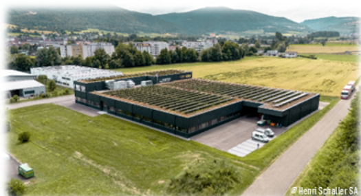
Site industriel avec une toiture végétalisée et des panneaux solaires à Bassecourt
