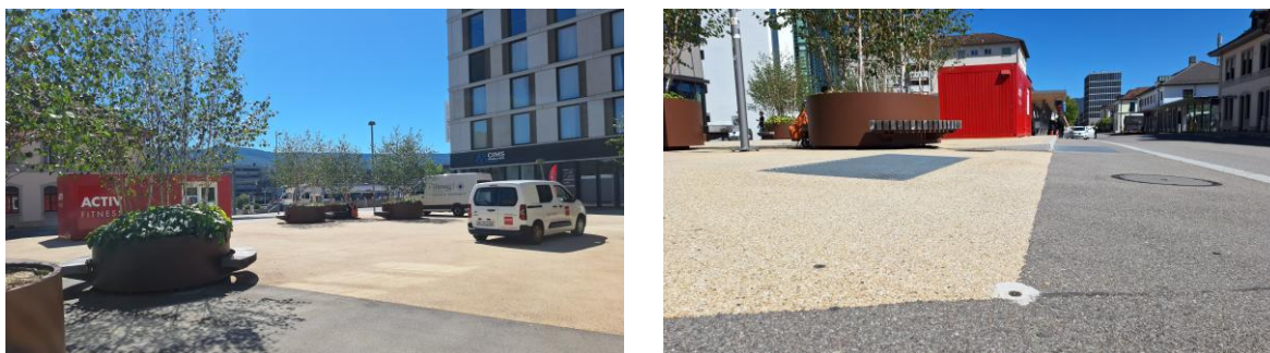
Figure 4 : Utilisation de matériaux à pouvoir réfléchissant dans le cadre d'un projet urbain à Delémont.
