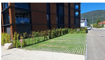
Revêtement « modulaire » : Dalles alvéolées engazonnées
