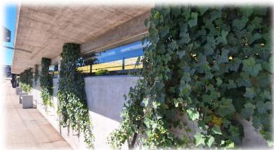
Végétalisation d'une façade à la gare de Delémont
