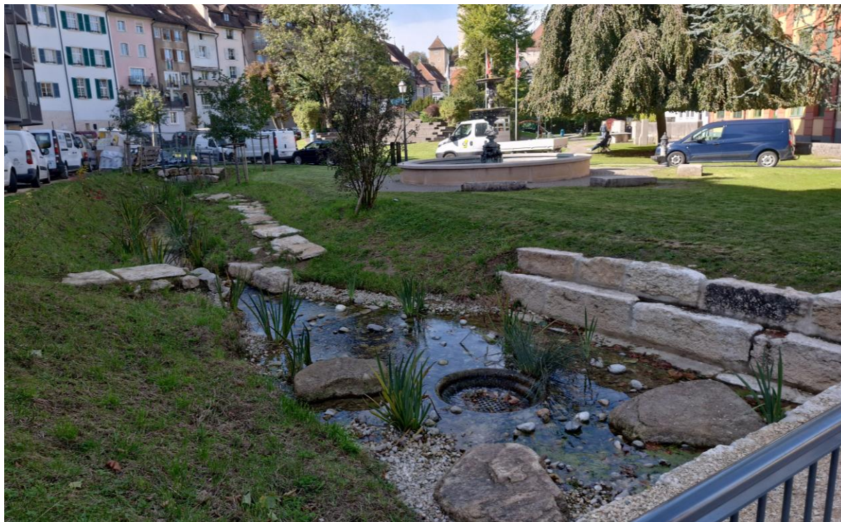
Figure 5 : Mise à ciel ouvert d'une résurgence d'un cours d'eau à Porrentruy.
