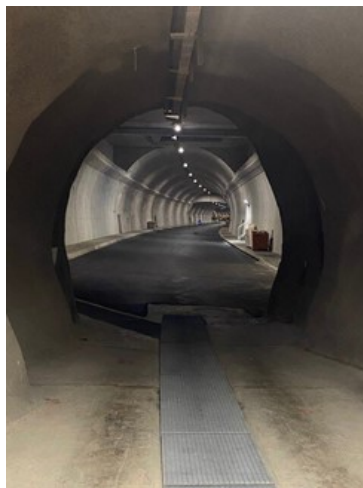
Vue sas sortie nord - Tunnel de Choindez Photo @Thierry Kläy
