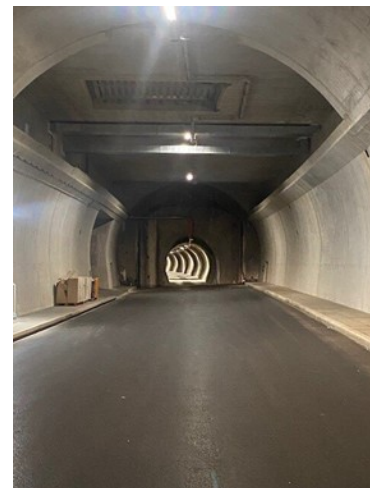
Sas sortie nord - Tunnel de Choindez Photo @Thierry Kläy
