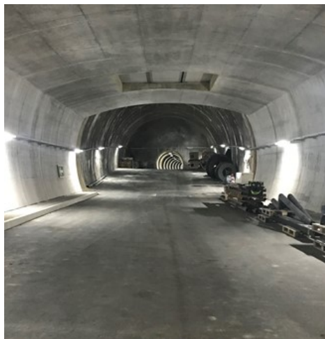
Sas sortie sud - Tunnel du Mt-Russelin Photo @Eloïse Wunderlich
