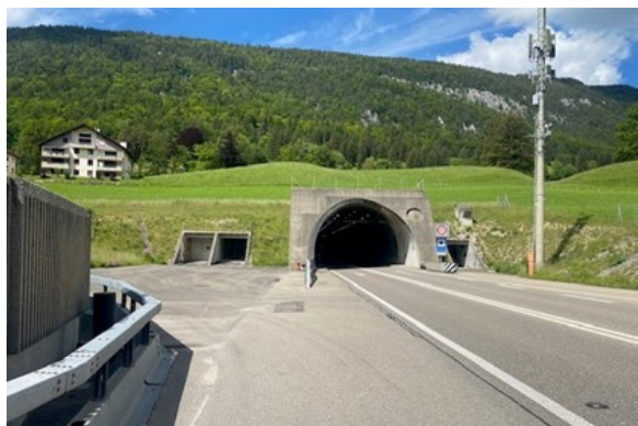
Entrée sud du tunnel bidirectionnel du Raimeux Photo @Thierry Kläy
