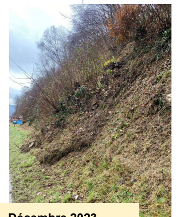
Décembre 2023 N18 / Delémont-Soyhières
