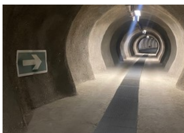
Panneau « Sortie » - Tunnel de Choindez Photo @Thierry Kläy
