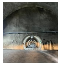
Sas sortie de galerie - Tunnel du Mt-Russelin Photo @Thierry Kläy
