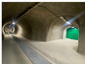
Galerie de sécurité - Tunnel de Choindez Photo @Thierry Kläy
