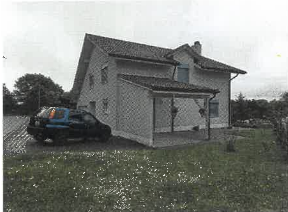
Façades Nord et ouest
