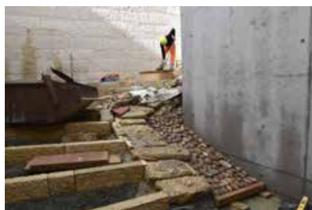
Fig. 2.65 (à gauche) Porrentruy – Château. Début du pavage en galets entre la canalisation en pierres et le mur en béton. Photo P.-A. Borgeaud, OCC-SAP
