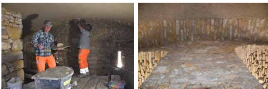
Fig. 2.77 (à gauche) Porrentruy – Château. Crépissage de la voûte de la cave-prison. Photo P.-A. Borgeaud, OCC-SAP
