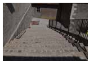
Fig. 2.72 (au milieu) Porrentruy – Château. Jointoyage des pavés avec un mortier beige. Photo P.-A. Borgeaud, OCC-SAP
