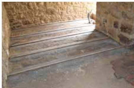
Fig. 2.79 (à gauche) Porrentruy – Château. Dernières réparations des murs de la cave-prison. Photo P.-A. Borgeaud, OCC-SAP
