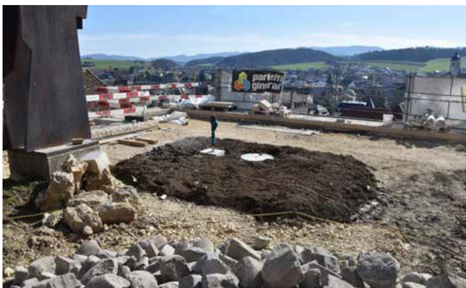
Fig. 2.76 Porrentruy – Château. Aménagements au-dessus de la cave-prison avec notamment une bâche imperméable placée sous la chaille et le carré de terre. Photo P.-A. Borgeaud, OCC-SAP
