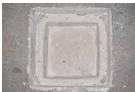
Fig. 2.103 (à gauche) Saint-Ursanne – Collégiale. Le sépulcre muni de sa pierre de couvercle. Au premier plan, la petite cavité facilitant la préhension du couvercle.
