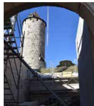
Fig. 2.53 Porrentruy – Château. Coup d'oeil sur la tour Réfous et le nouvel abri à boulets depuis la poterne ouverte. Photo P.-A. Borgeaud, OCC-SAP
