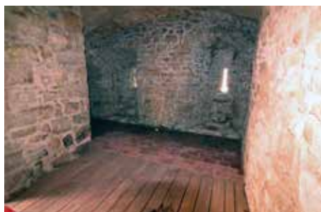
Fig. 2.81 (à gauche) Porrentruy – Château. Le sol de carreaux de céramique restauré et le nouveau plancher posé. Un discret éclairage est également installé. Photo P.-A. Borgeaud, OCC-SAP
