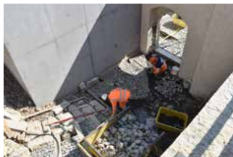
Fig. 2.69 (à gauche) Porrentruy – Château. Début du pavage du replat devant l'entrée de la cave-prison. Photo P.-A. Borgeaud, OCC-SAP
