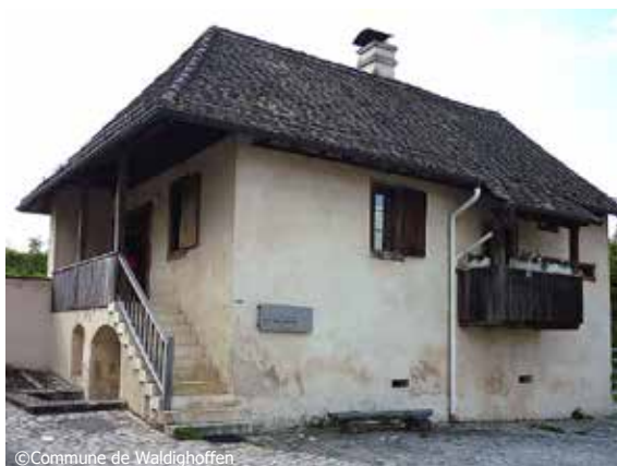
Figure 4 : Musée du Löwenbourg situé dans le bâtiment de l'ancienne fromagerie du domaine
