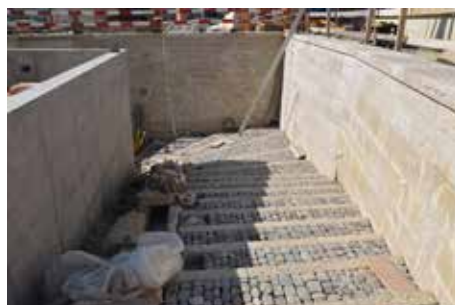
Fig. 2.67 (à gauche) Porrentruy – Château. Pavage de la rampe d'escalier arrivant dans la cour du château. Photo P.-A. Borgeaud, OCC-SAP
