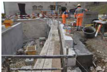
Fig. 2.54 (à gauche) Porrentruy – Château. Reconstruction du mur 2 de soutènement de la partie haute de l'escalier. Photo P.-A. Borgeaud, OCC-SAP
