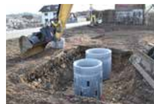
Fig. 2.126 Vicques – Route de Courroux. Vue d'ensemble de la fouille et des deux chambres, vue nord-est. Photo G. Luisoni, OCC-SAP
