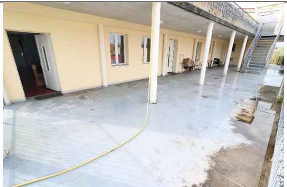
136_Accès - 1er-2ème - Gare 17
