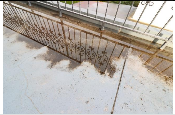
138_Accès - 1er-2ème - Gare 17
