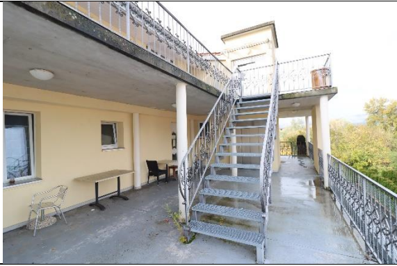
137_Accès - 1er-2ème - Gare 17
