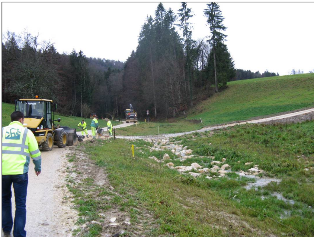
Travaux à CCM
