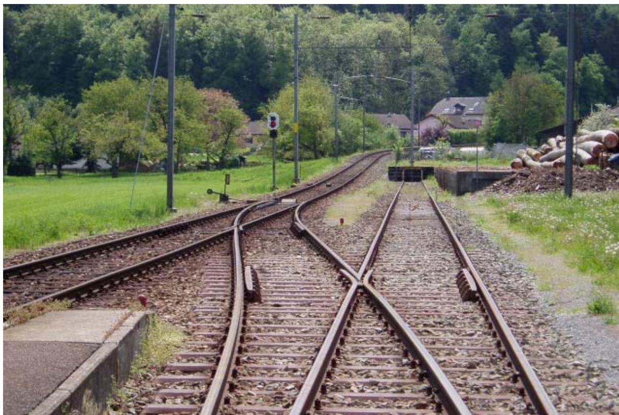
Fig. 7. Direction Porrentruy, voie de débord et branchement
