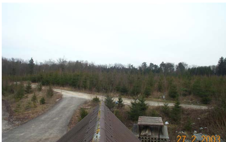
Figure 4.1.4 : Vue actuelle (2003) de la décharge : chemin d'accès système de couverture avec reboisement
