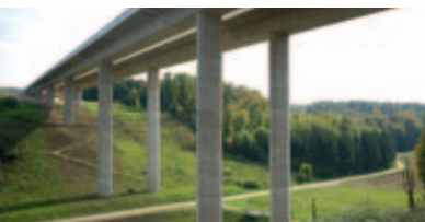
Viaducs des Grand'Combes page 17
