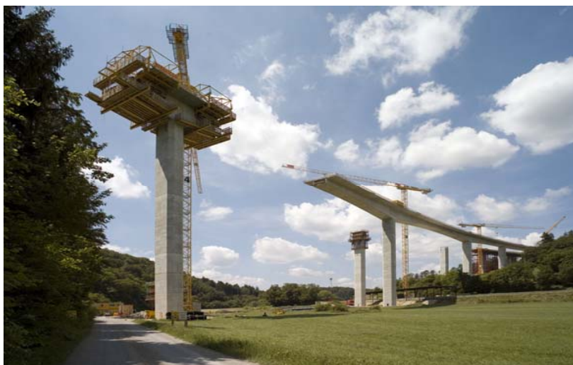
A16 - Viaduc du Creugenat
