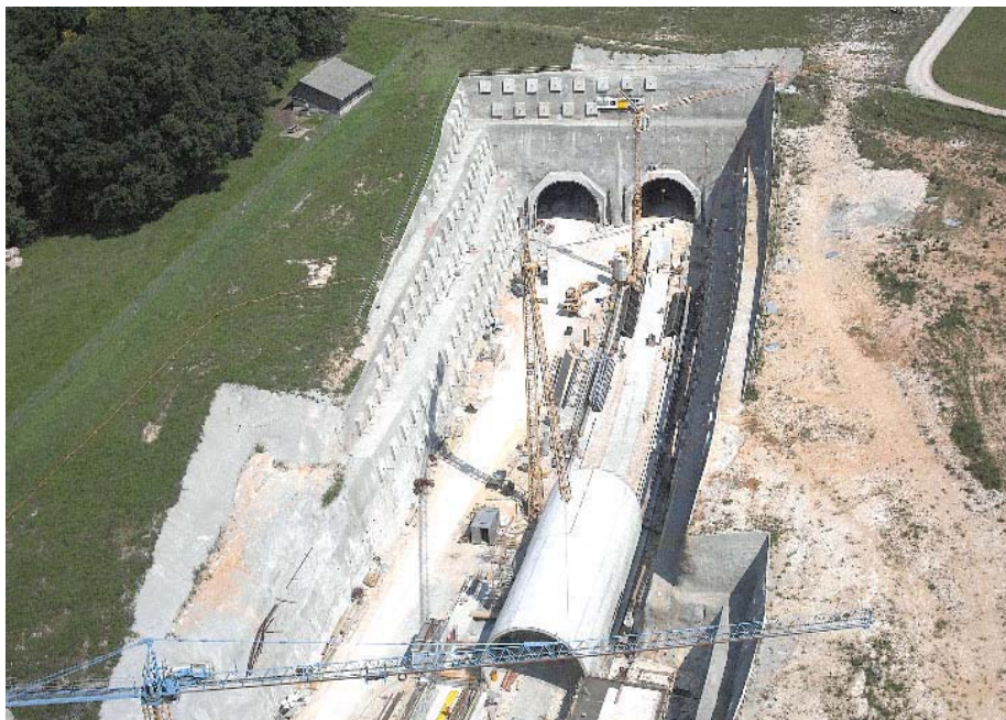
A16 (évitement de Porrentruy): portail ouest du tunnel du Banné, secteur de l'Oiselier
