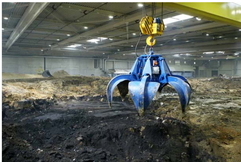
Abb. 2: Greifer für den Aushub der Abfälle
