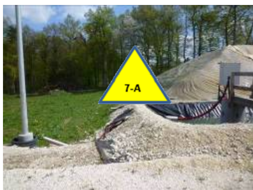
En bordure du réservoir de rétention dépôt G-est
