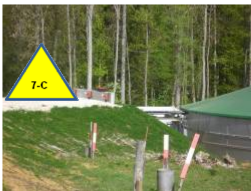
Chemin au près des raccords d'eau d'extinction
