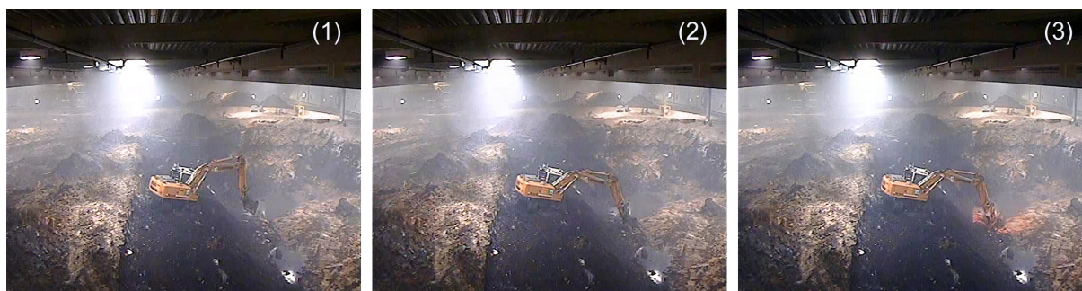
Figure 2: Images saisies par une caméra de surveillance, juste avant l'explosion. Sur l'image (3) on distingue clairement l'initiation de l'explosion ; dès l'image suivante, la caméra est hors d'usage. La couleur orangée de la flamme suggère une réaction avec du calcium (de fortes concentrations de calcium ont été observées dans les échantillons analysés).
