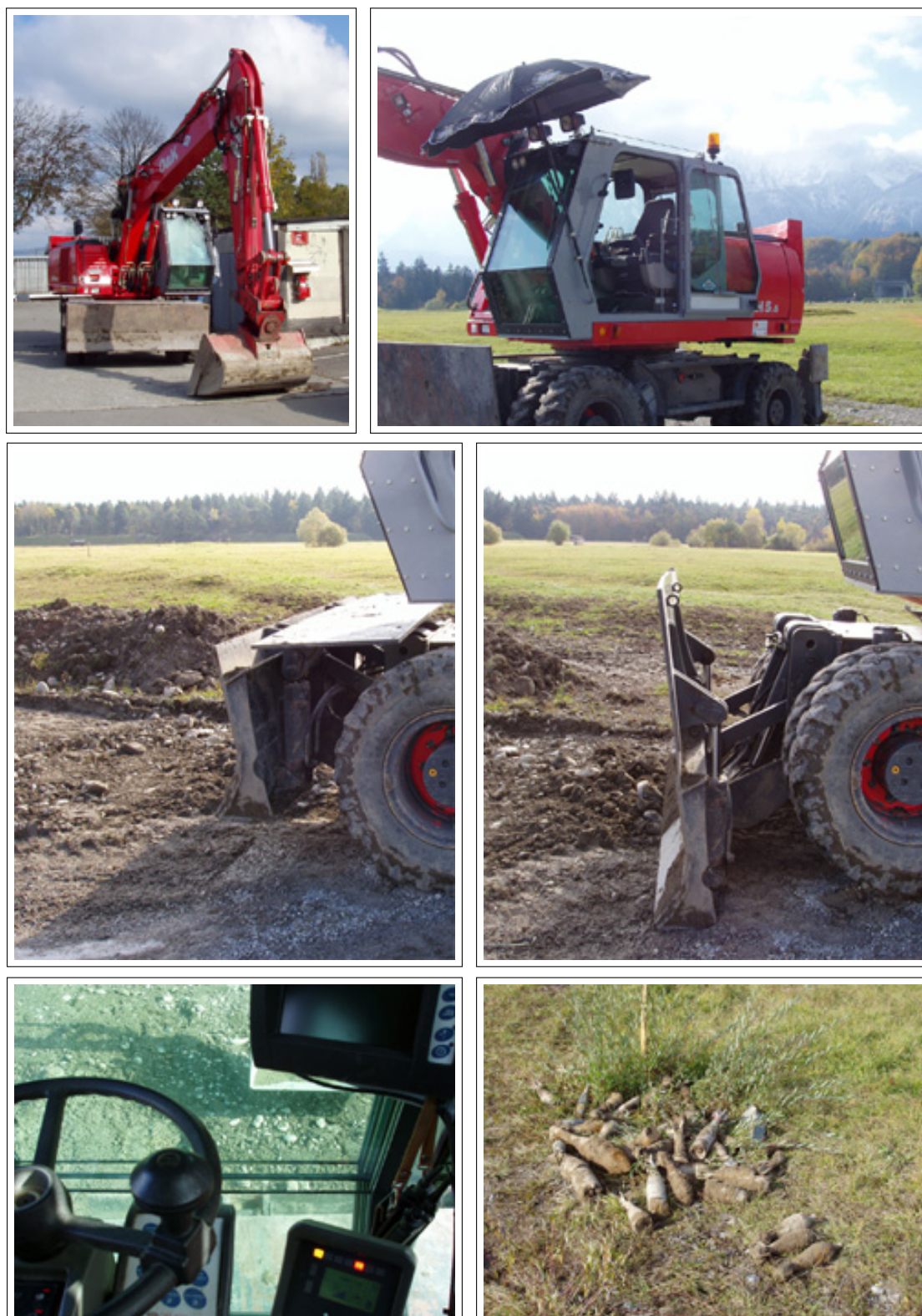
Figure 6: En haut, à gauche, vue générale de la pelleuse modifiée pour le travail dans des terrains contenant des munitions non explosées; le blindage de la cabine est certifié contre l'explosion d'obus d'artillerie de 15.5 cm. En haut, à droite, vue de la cabine pressurisée; sur l'avant, la cabine est protégée par un vitrage blindé triple; sur les côtés et l'arrière de la cabine, le vitrage est également blindé. Le plancher de la cabine est renforcé par une plaque d'acier. Ligne du milieu: à gauche, la lame avant relevée; à droite, la lame avant abaissée, avec une plaque de protection contre les éclats. En bas à gauche, vue du vitrage blindé triple sur l'avant de la cabine. En bas à droite, quelques munitions (principalement des obus de 8.1 cm) non explosées déterrées avec cet machine le jour où ces photographies ont été faites.
