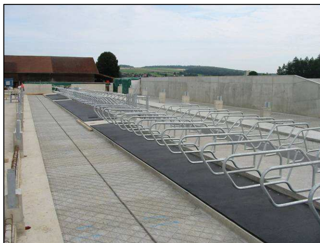
Construction d'une étable
