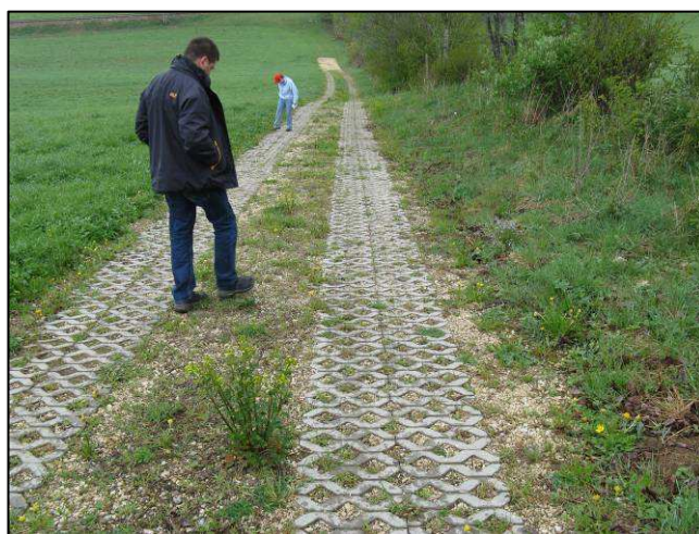
Réception de travaux, remaniement parcellaire du Noirmont
