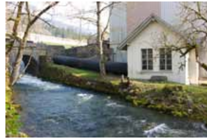
Doux. Conduite forcée et maisonnette de l'usine
