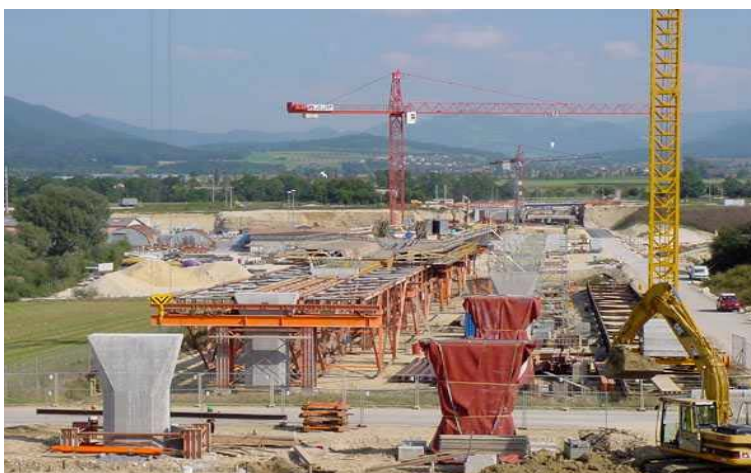
Chantier de la Transjurane à l'est de Delémont : le Viaduc du Tayment à la Ballastière
