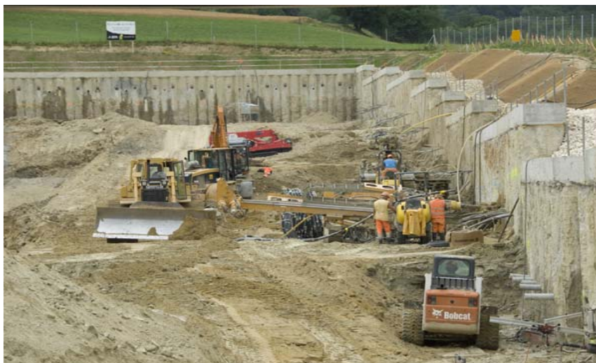
A16 - Fouille nord Tunnel de Choindéz
