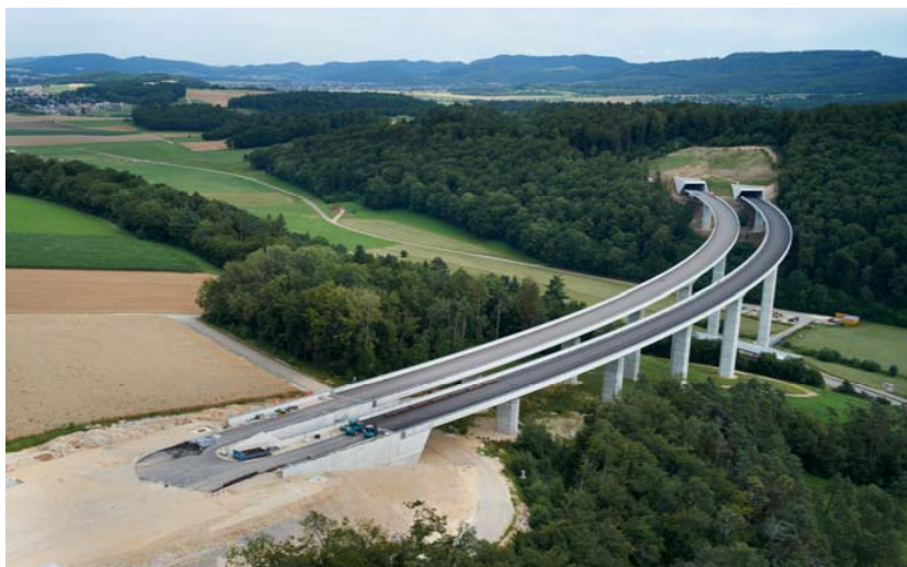
A16 - Viaduc du Creugenat, Courtedoux.
