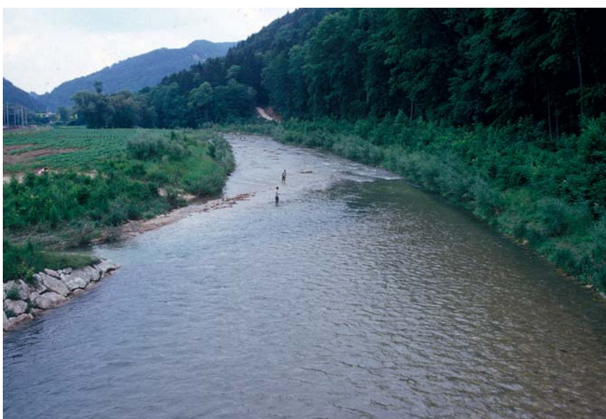
1988 quatre ans après le début des travaux, la nature se développe gentiment et le cours d'eau présente déjà un aspect plus naturel
