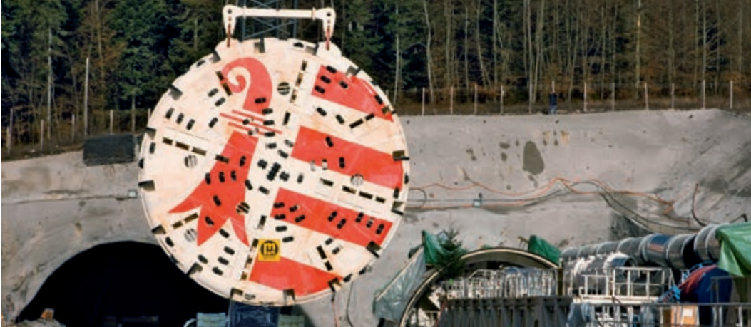
Tunnel de Bure: Réalisation 2007–2011
