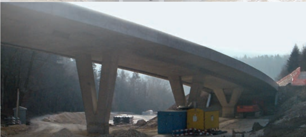
Pont de la Combe Ronde: Réalisation 2004–2005
