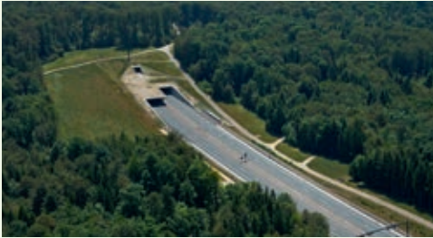
Portail nord des tunnels du Neu-Bois, sur la section 2A.
