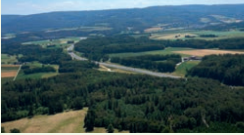
L'A16 entre Bure et Porrentruy traverse une région à alternance entre zone agricole et grands massifs boisés.
