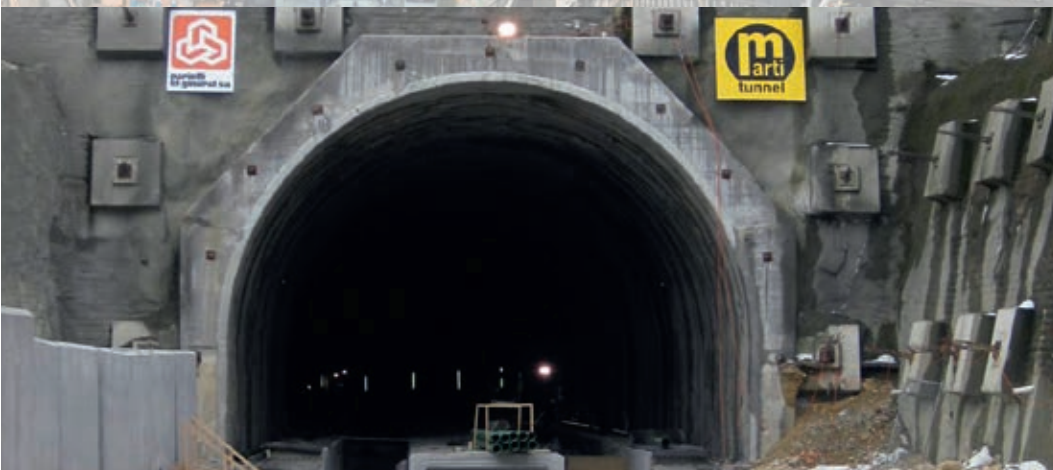
Tunnel du Bois de Montaigne: Réalisation 2008–2010
