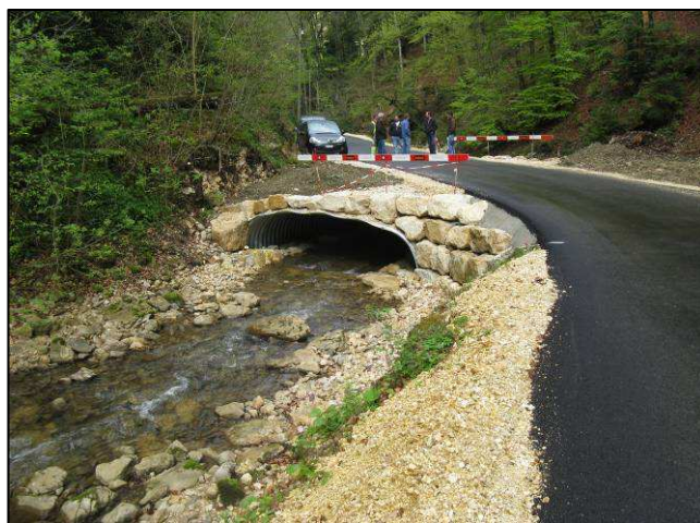
Réfection route Vermes - Envelier
