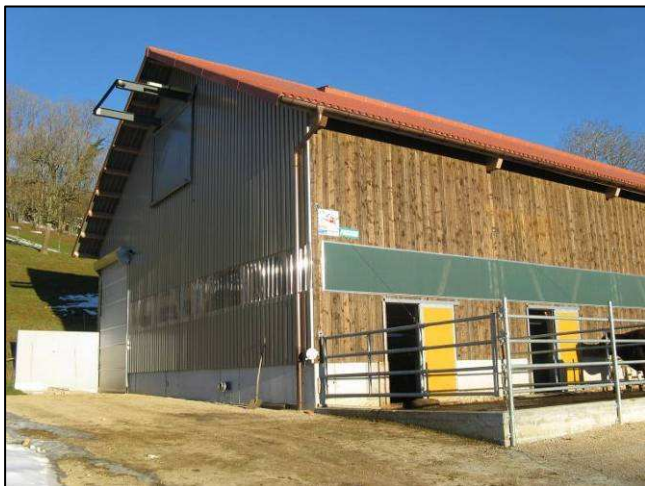
Walter Gerber, nouvelle étable, Montrusselin, zone de montagne 2
